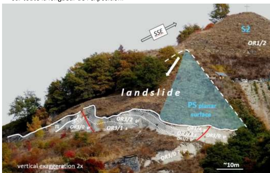
FIGURE 64 Structure et stratigraphie de l'exposition OR3. Les failles (lignes rouges) semblent être liées à un glissement de terrain (ligne blanche en pointillés), ce qui expliquerait la variabilité des pendages et des directions de pendage mesurés. L'alternance, cependant, plonge généralement vers le SSE. Les surfaces planes PS (bleu clair) et S2 ont été générées en période de pré-liquidité.
